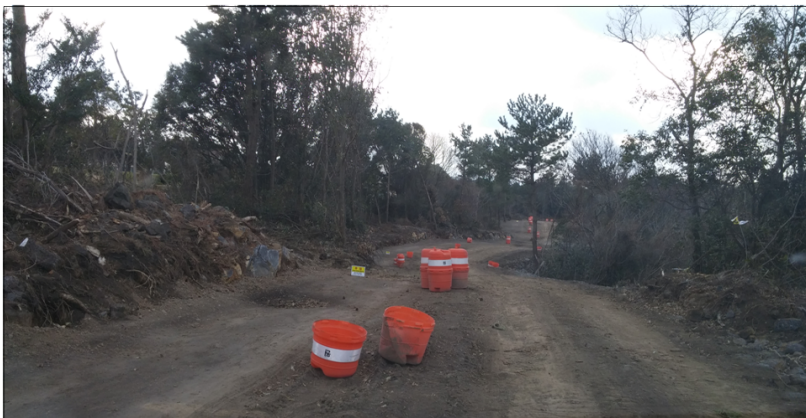
그림 5 지중선로 굴착공사 작업현장
